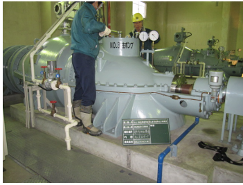
写真1 ポンプ設備点検
