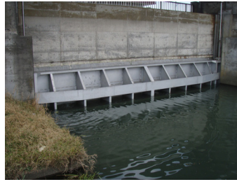
写真2 ゲート設備点検
